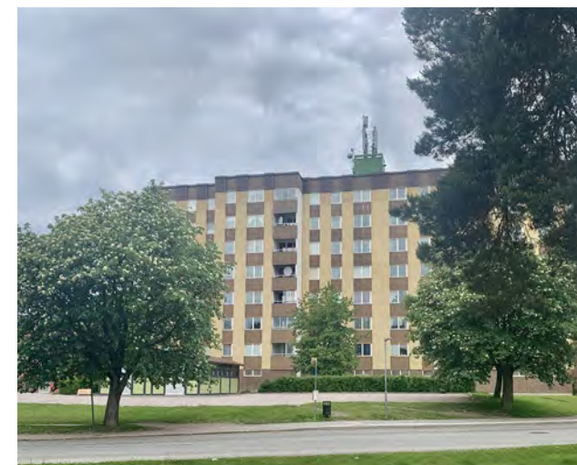
Före – en dåligt utnyttjad asfaltsyta nära vägen.
