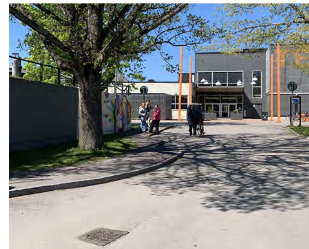
Före – parkeringsplatser och en utfart.
